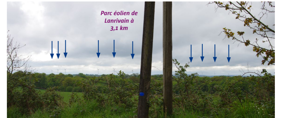
Vue en direction du sud-est sur le parc de Lanrivain dont on distingue bien les deux alignements d'éoliennes, dont le plus proche est composé de deux sous-parties de trois éoliennes.
